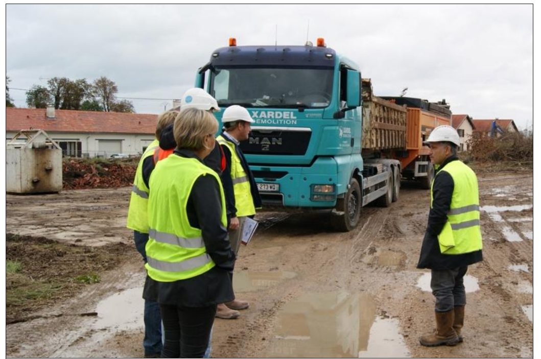
■ De régulières visites de chantier sont réalisées, en présence de l'entreprise et des administrations publiques, pour suivre l'avancement des travaux.
